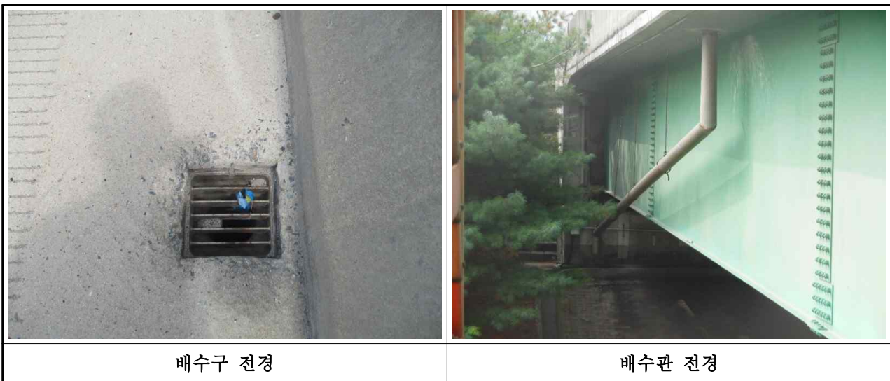
【그림 3-30】 금성교(춘천) 배수시설 전경
