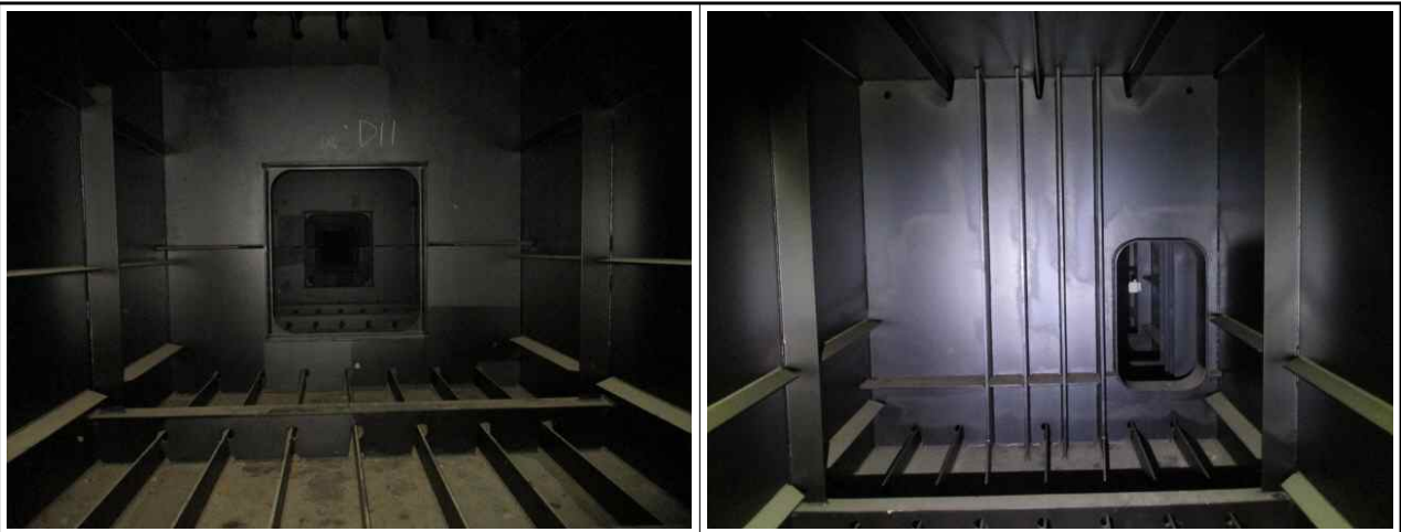
Steel Box Girder 내부 격벽 전경
