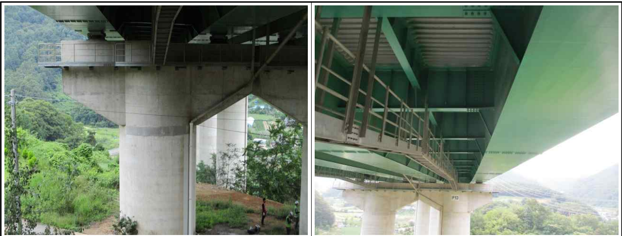
교각 점검시설 전경
