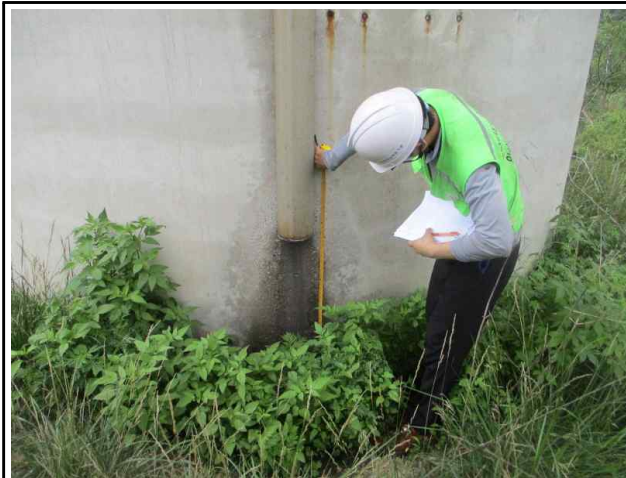
도보를 이용한 외관조사(부산방향) 통풍 안전모 특허 제10-0816556호
