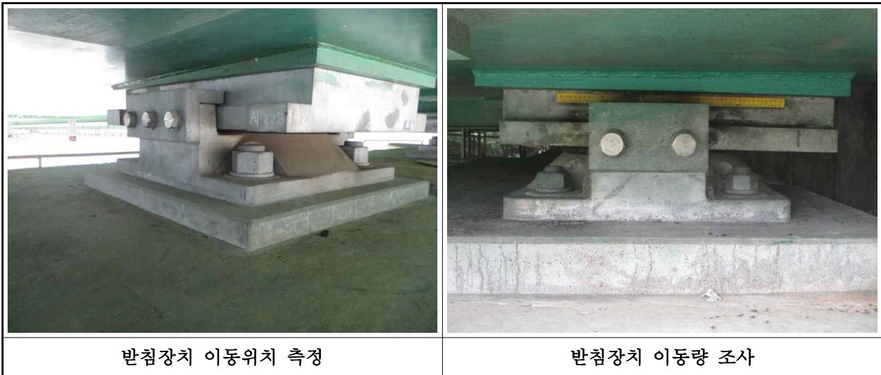
【표 3-13】 부산방향 - 교량받침 가동상태 검토결과
