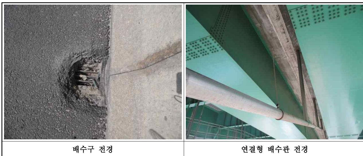
【그림 3-15】 금성교(부산) 배수시설 전경
