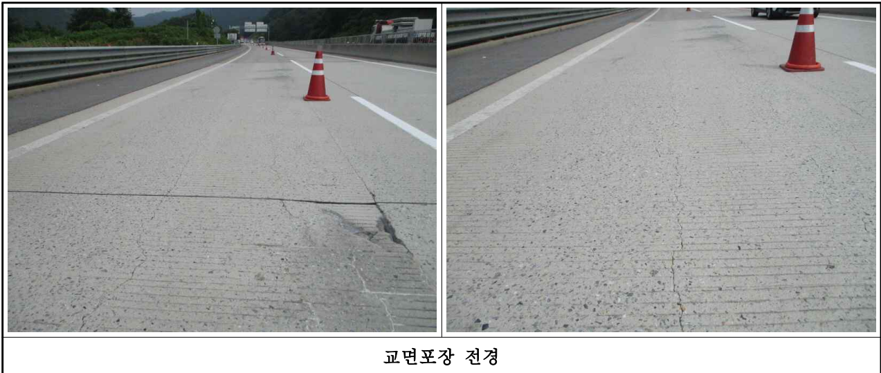
【그림 3-29】 금성교(춘천) 교면포장 전경
