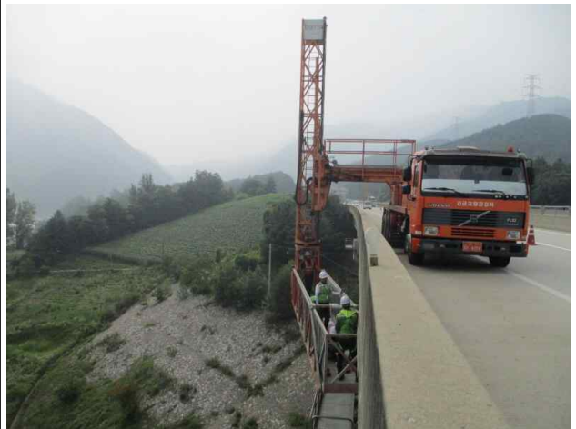
교량점검차를 이용한 외관조사(춘천방향)
