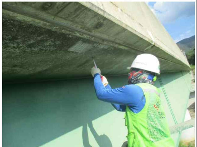
탄산화 깊이 측정
