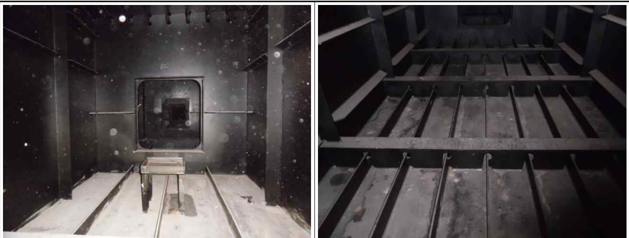
Steel Box Girder 내부 전경
