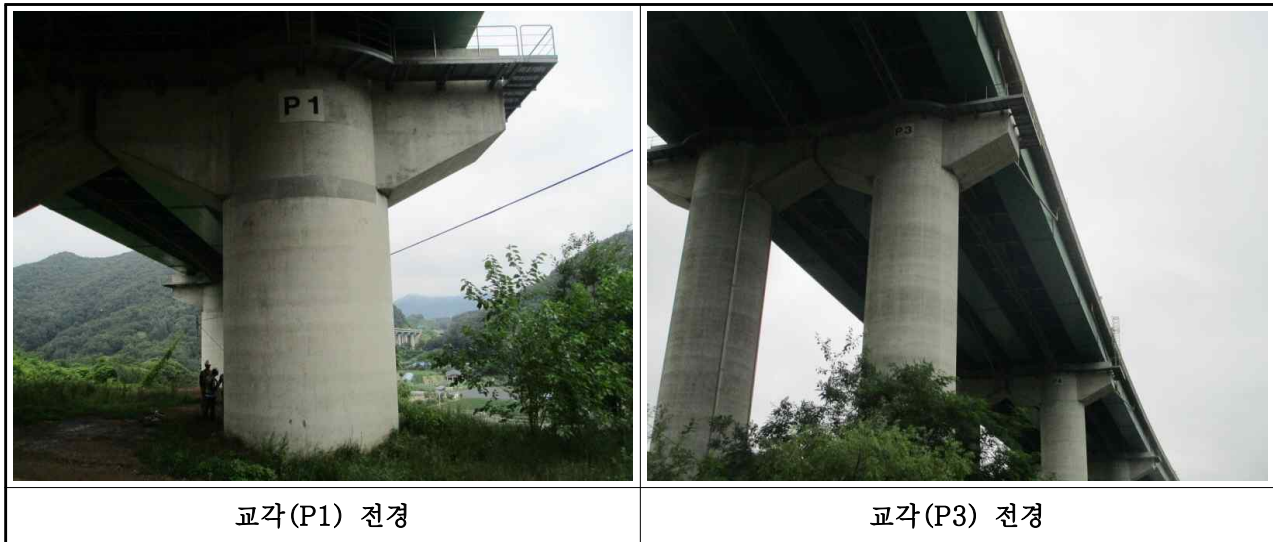
【그림 3-24】 금성교(춘천) 교각 전경
