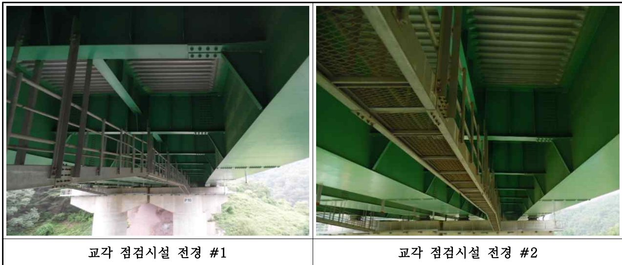
【그림 3-31】 금성교(춘천) 기타 부대시설 전경
