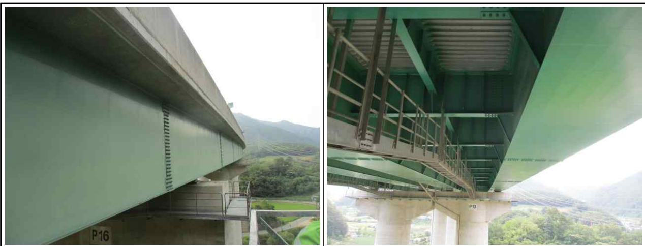
Steel Box Girder 외부 전경
