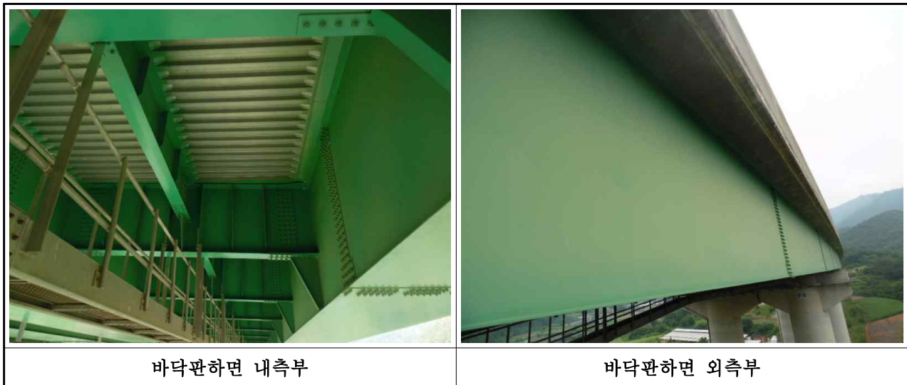
【그림 3-18】 금성교(춘천) 바닥판하면 전경
