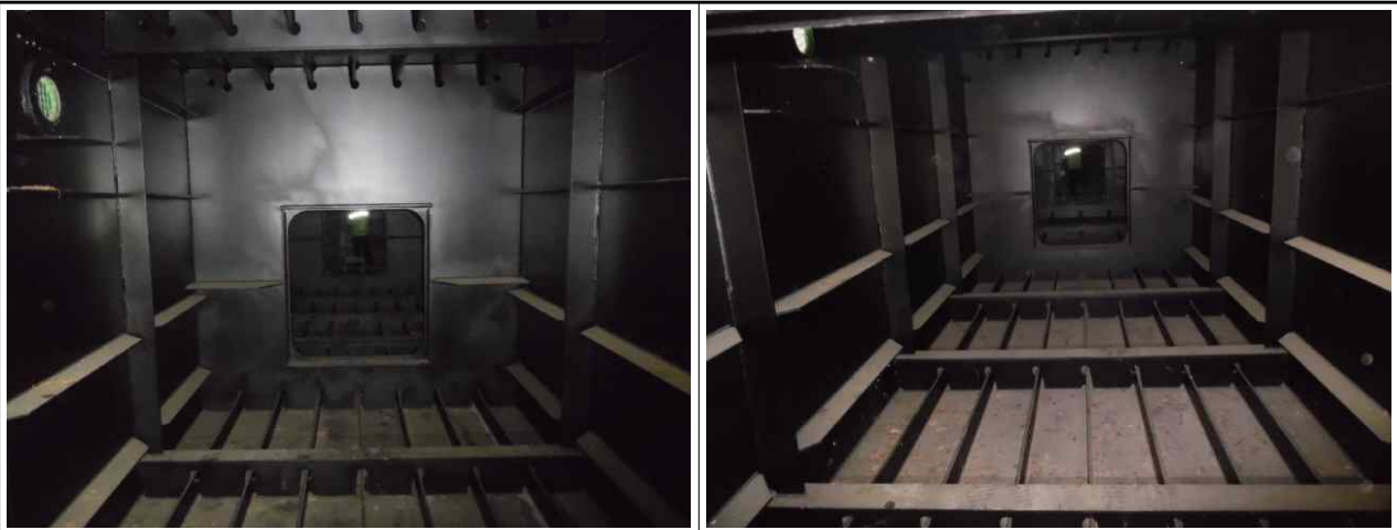
Steel Box Girder 내부 격벽 전경
