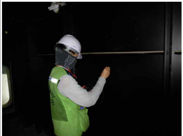
거터내부 도막두께 측정(춘천방향)
