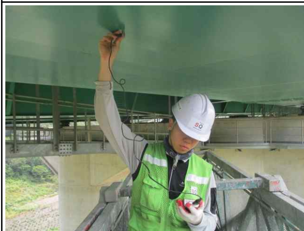
도막두께 측정 (부산방향)
