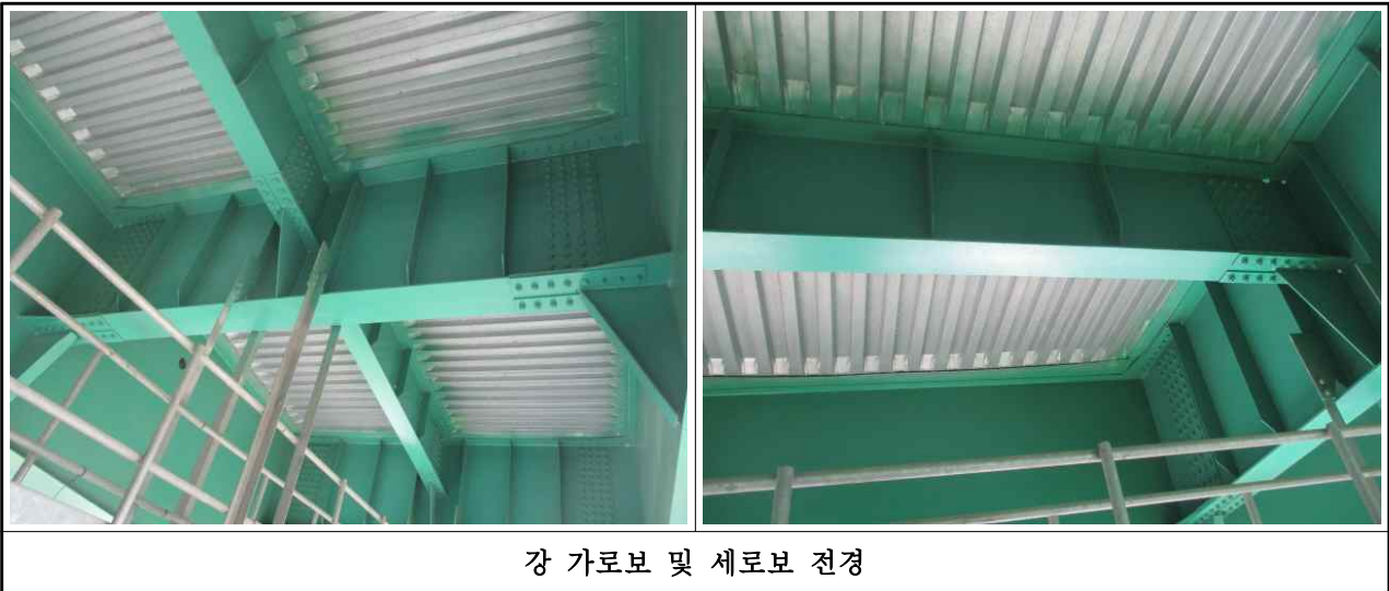
【그림 3-7】 금성교(부산) 강 가로보 및 세로보 전경
