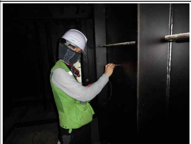
도막두께 측정 (춘천방향)
