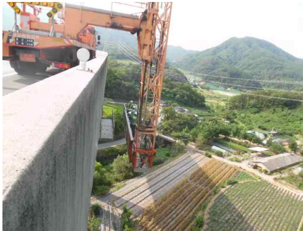
교량점검차를 이용한 외관조사(부산방향)
