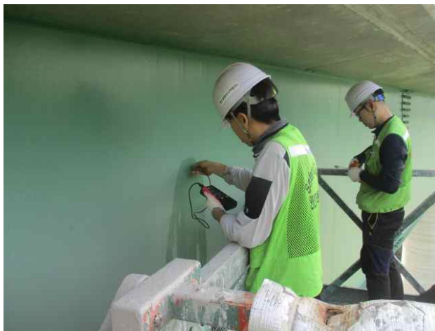
거터외부 도막두께 측정(부산방향)
